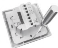
Рисунок 5. Демонтаж лицевой панели
